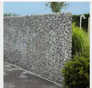
4. stabiele en rechte wand door goede fundering en uitlijning
