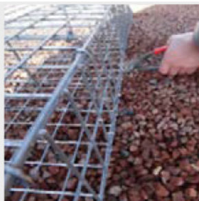
2. sluiten met ringkrammen
